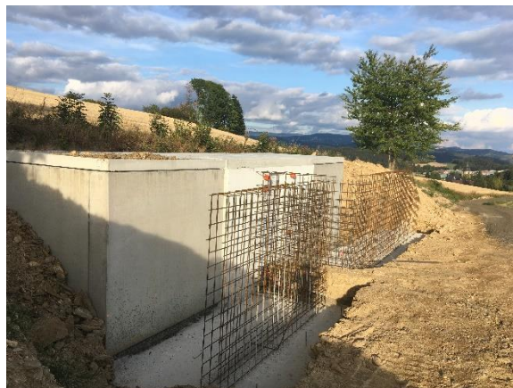
Práce okolo vodojemu, podzim 2022
