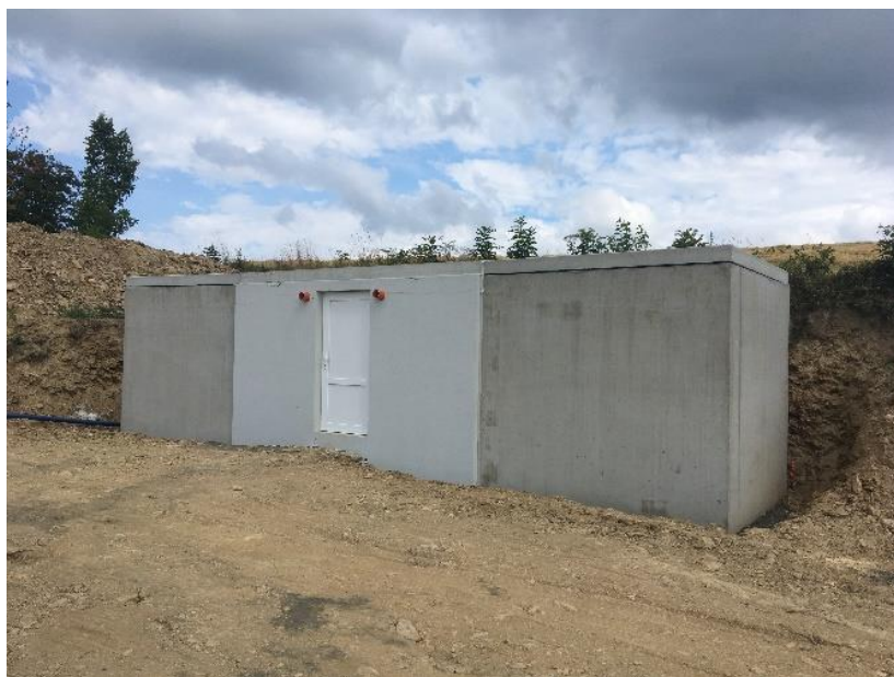
Osazený vodojem, listopad 2022
