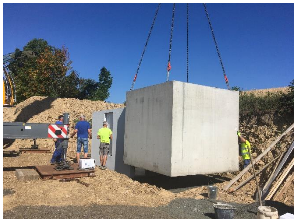
Práce na vodojemu, srpen 2022
