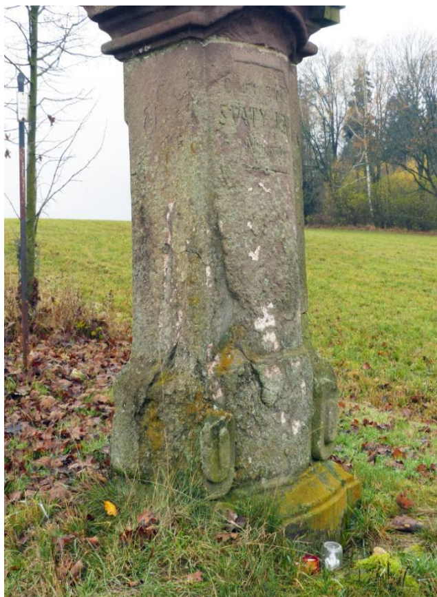
Celá spodní část a zejména levá voluta byla v havarijním stavu, rozsáhlé napadení povrchů lišejníky
