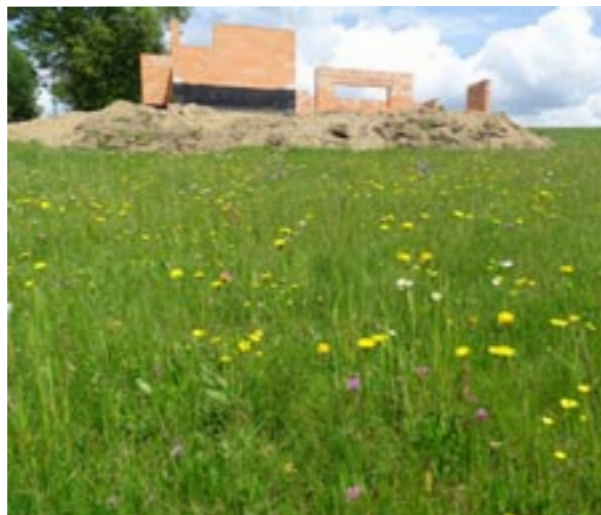
1. výstavba na Křižlicích
